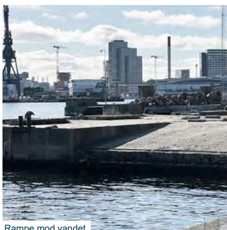
Rampe mod vandet
